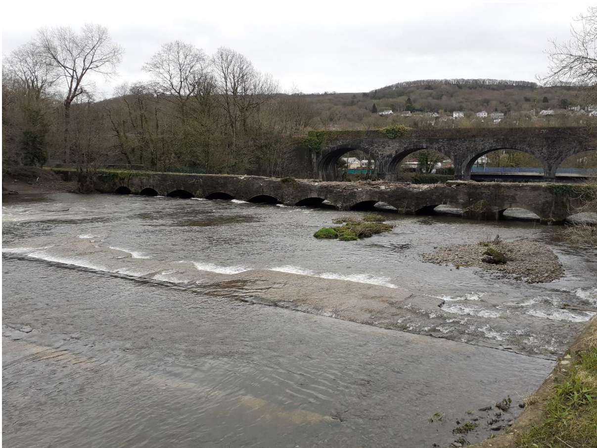
Delwedd 2 – Pont Ddŵr Camlas Tenant
